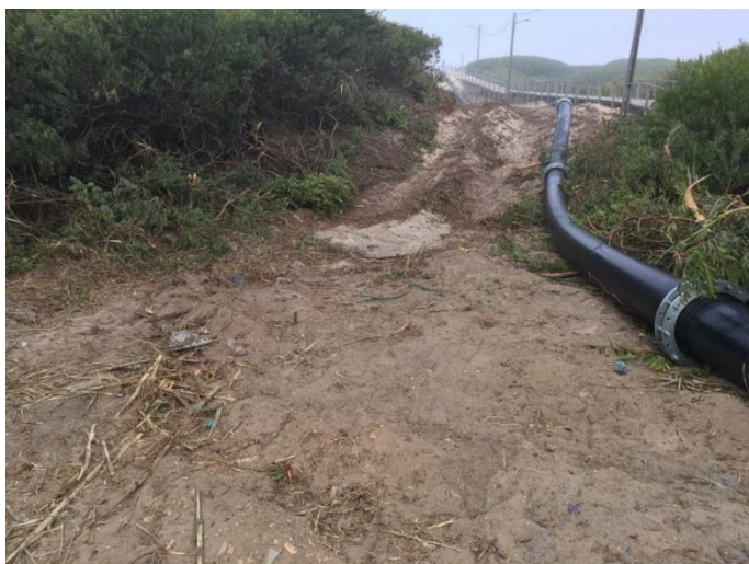
Figura 22: Zona desmatada para a passagem da linha
