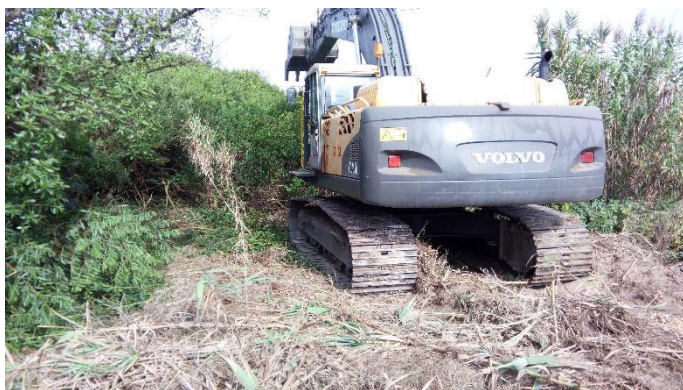
Figura 13: Início da desmatção mecânica das dunas
