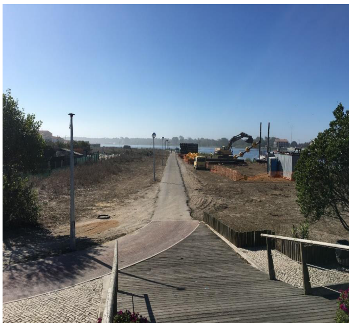
Figura 1: Vista geral do estaleiro de montagem da draga
