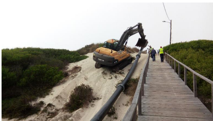
Figura 16: Montagem da linha de transposição de sedimentos sobre as dunas
