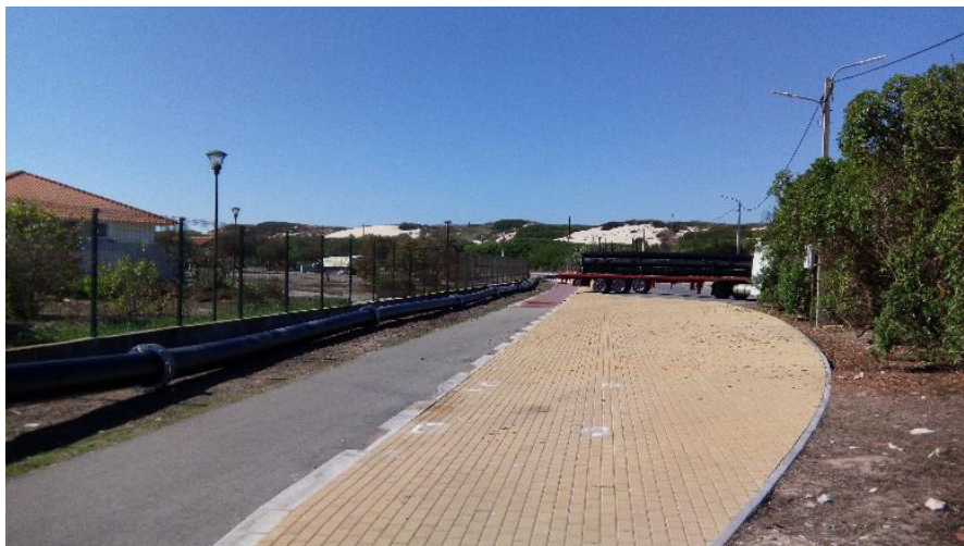
Figura 19: Perspectiva da linha de transposição de sedimentos, junto à ciclovia
