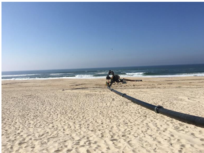
Figura 39: Finalização da montagem da linha
