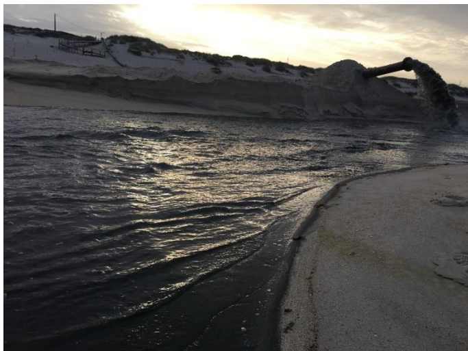
Figura 78: Vista geral do depósito
