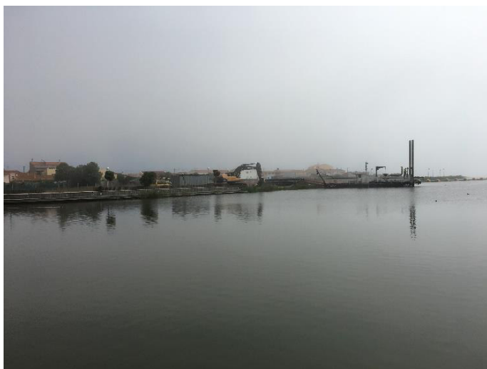
Figura 8: Vista geral do estaleiro de montagem da draga
