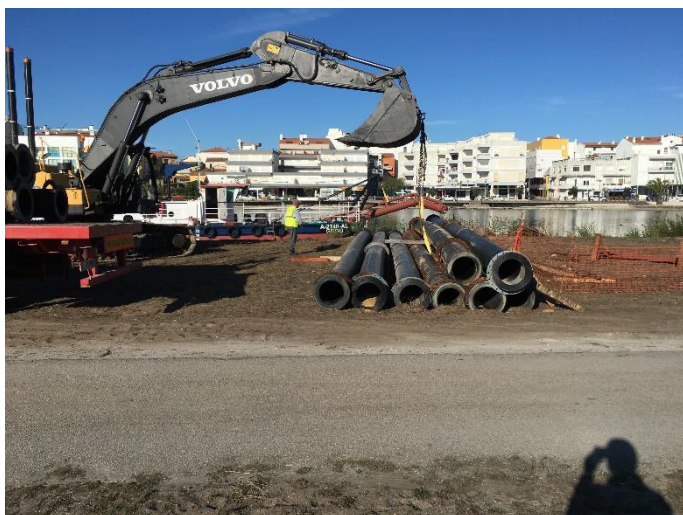
Figura 8: Montagem da tubagem
