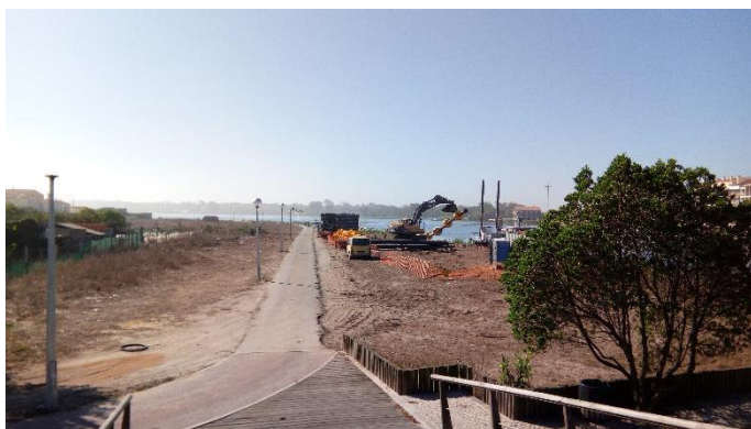
Figura 5: Trabalhos de montagem da linha de transposição de sedimentos na Barrinha
