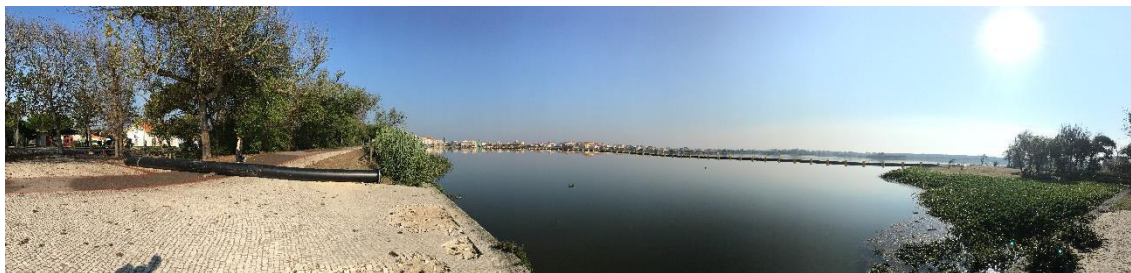
Figura 30: Panorâmica da margem oeste da Barrinha e da extensão da tubagem
