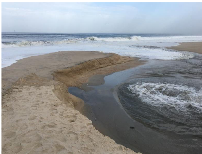
Figura 81: Intrusão do mar no depósito de descarga de dragados
