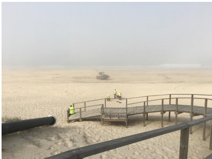
Figura 24: Equipa à espera da chegada de mais tubos
