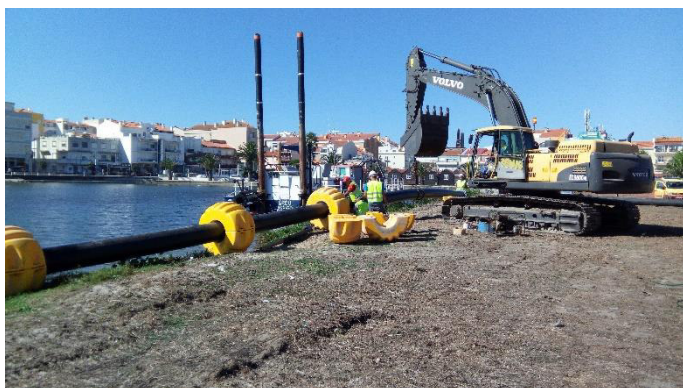
Figura 7: Montagem da linha de transposição de sedimentos
