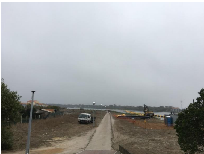
Figura 10: Geral do estaleiro de montagem
