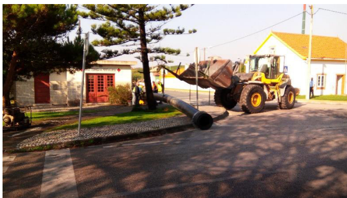
Figura 34: Montagem da linha de transposição de sedimentos na ciclovia
