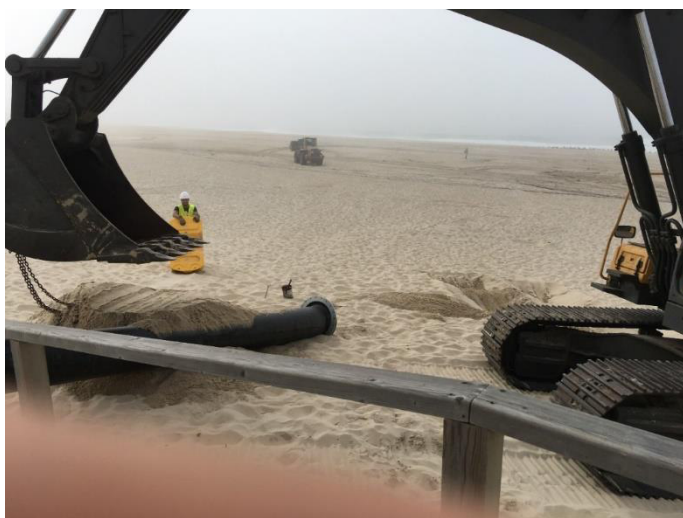
Figura 25: Colocação de areia para nivelar a linha
