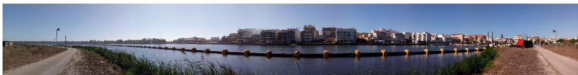
Figura 6: Panorâmica dos trabalhos de montagem da linha de transposição de sedimentos na Barrinha
