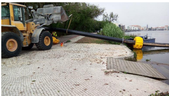
Figura 36: Montagem da linha de transposição de sedimentos no Parque da Barrinha
