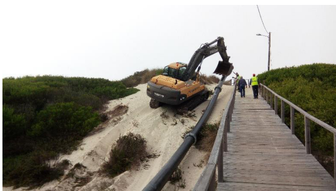
Figura 213: Montagem da linha de transposição de sedimentos sobre as dunas
