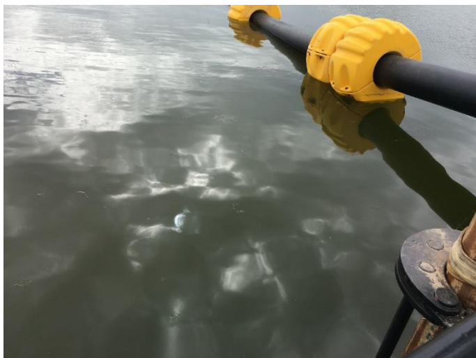
Figura 69: Visibilidade da água na popa
