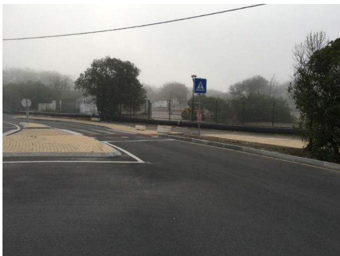
Figura 20: Tubagem montada na ciclovia
