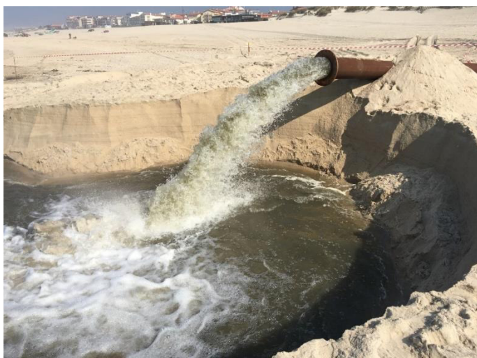
Figura 55: Limpeza da tubagem apenas com água (na imagem vem turva, transportando já algum sedimento)
