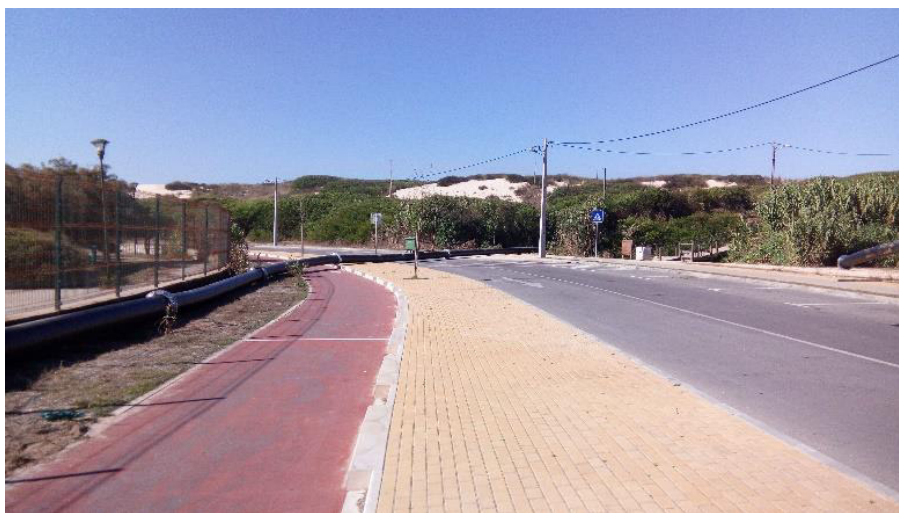
Figura 18: Montagem da linha de transposição de sedimentos, junto à ciclovia
