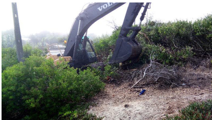
Figura 14: Continuação dos trabalhos de desmatção mecânica
