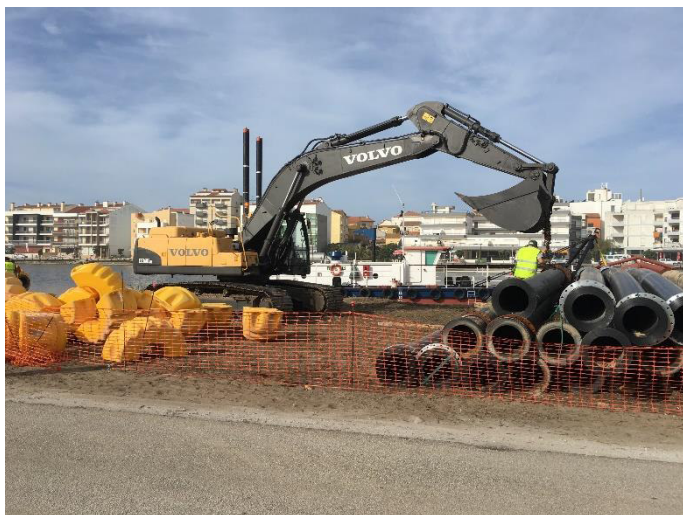
Figura 12: Montagem da tubagem
