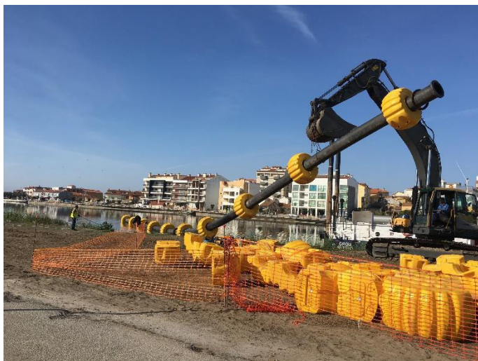
Figura 10: Montagem da tubagem
