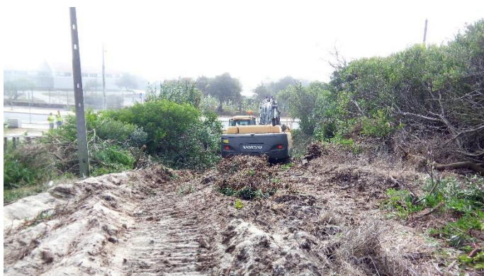
Figura 15: Perspectiva dos trabalhos de desmatção mecânica
