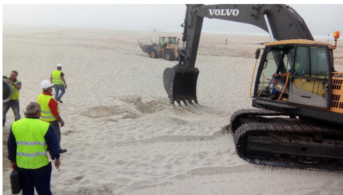
Figura 27: Acompanhamento das afecções directas por parte da giratória
