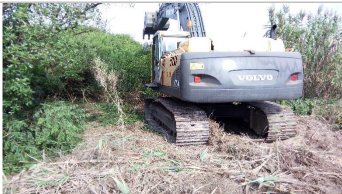
Figura 211: Desmatção das dunas com recurso a giratória (360°)
