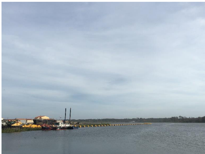
Figura 13: Comprimento da linha no final do dia
