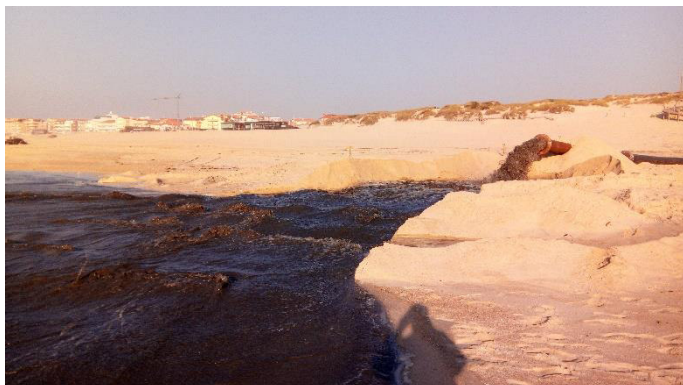
Figura 48: Perspectiva da deposição e do depósito de sedimentos na Praia de Mira
