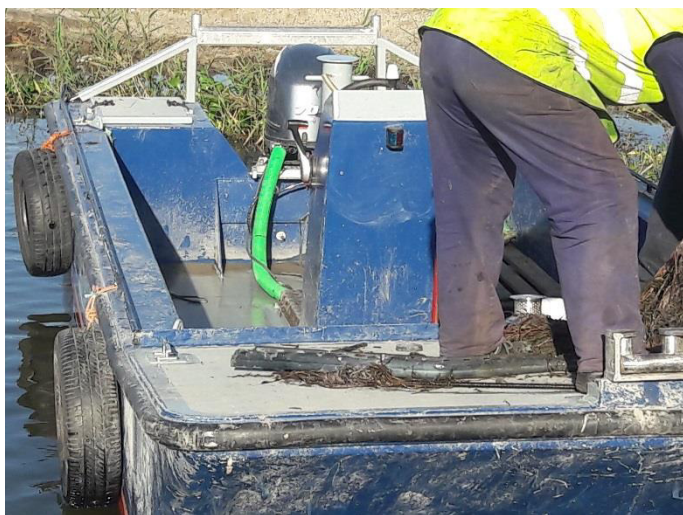
Figura 159: Limo e lixo urbano retirados na limpeza da cabeça da lança.
