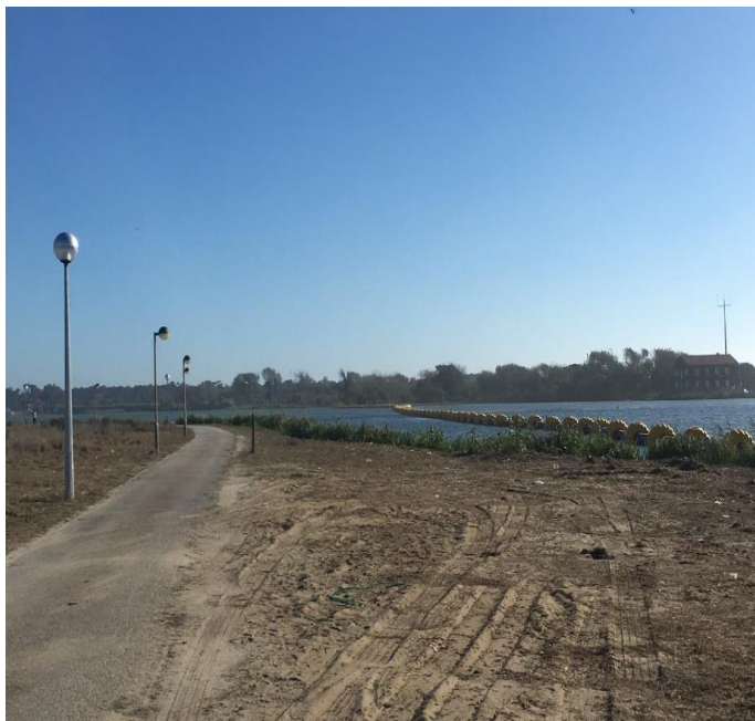
Figura 4: Trabalhos de montagem da linha de transposição de sedimentos da Barrinha
