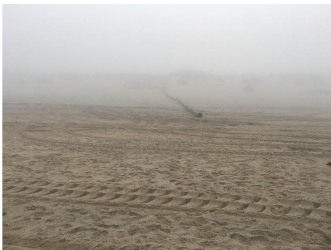
Figura 29: Extensão da tubagem, denotando bem o alcance da preia-mar em marés vivas
