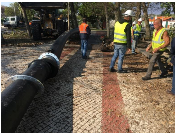
Figura 31: Montagem da tubagem no parque
