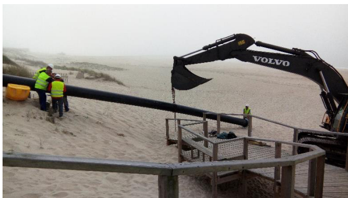
Figura 26: Acompanhamento da montagem da linha de transposição de sedimentos na praia
