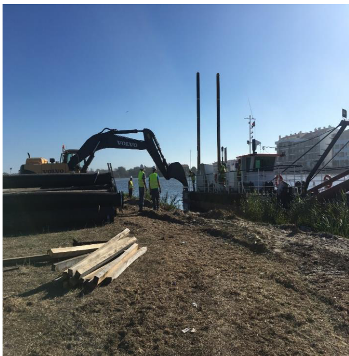
Figura 3: Equipa da execução da obra, draga Grou e Giratória
